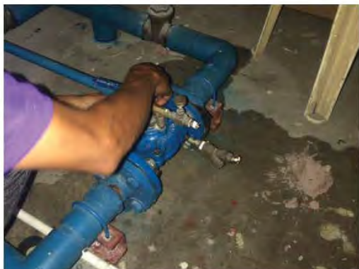
ช่างตรวจเช็คระบบน้ำใช้ ภาพที่ 2.2-9 ระบบน้ำใช้
